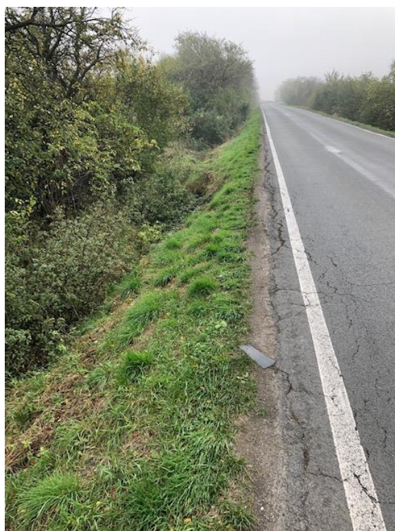
Odtržená krajnice i v dalším úseku komunikace
