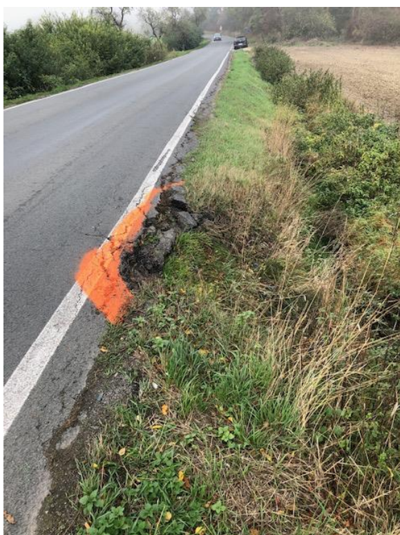
Odtržená krajnice i v dalším úseku komunikace
