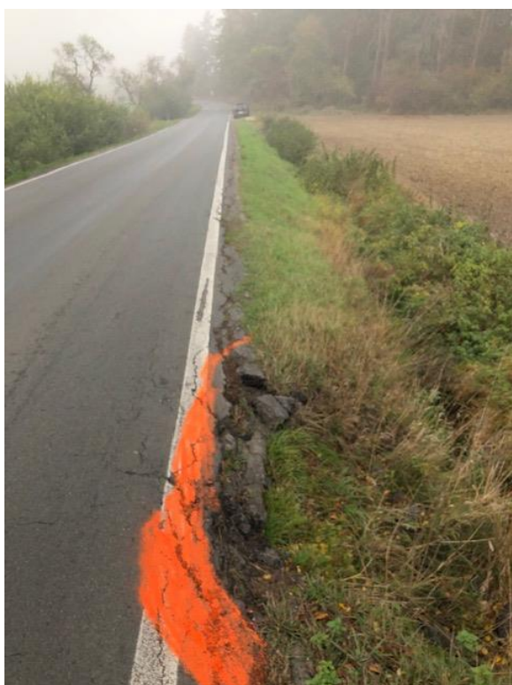
Zbytky prefabrikátů v korytě příkopu
